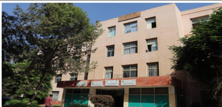
مبنى النبات الزراعي
